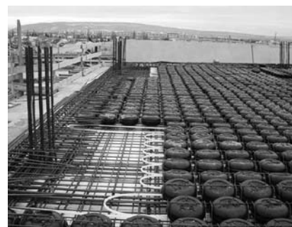
Abb. 4: Verlegen der Cobias Elemente auf der Bewehrung. Deutlich sichtbar die Leitungen für die Bauteilaktivierung.
