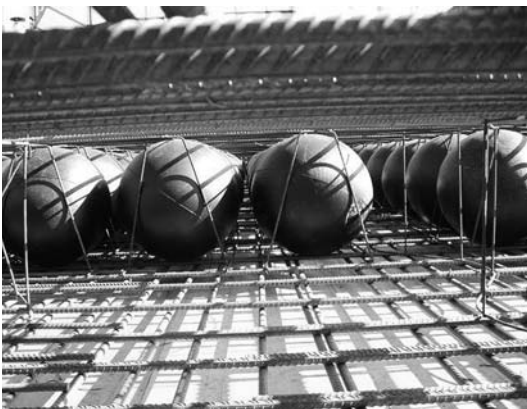
Abb. 1: Cobiax-Kugeln im Bewehrungskorb auf Schalung
