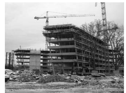
Abb. 5: Rohbau Tower Siemens City Abbildungen und Fotos: Cobias Technologies GmbH
