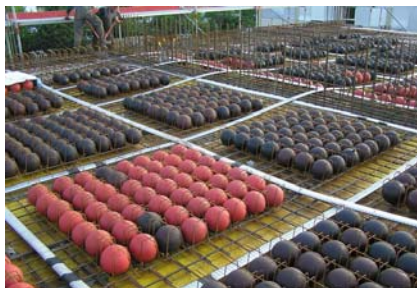
Ein Beispiel verlegter Hohlkörpermodule. (Bild pd)
