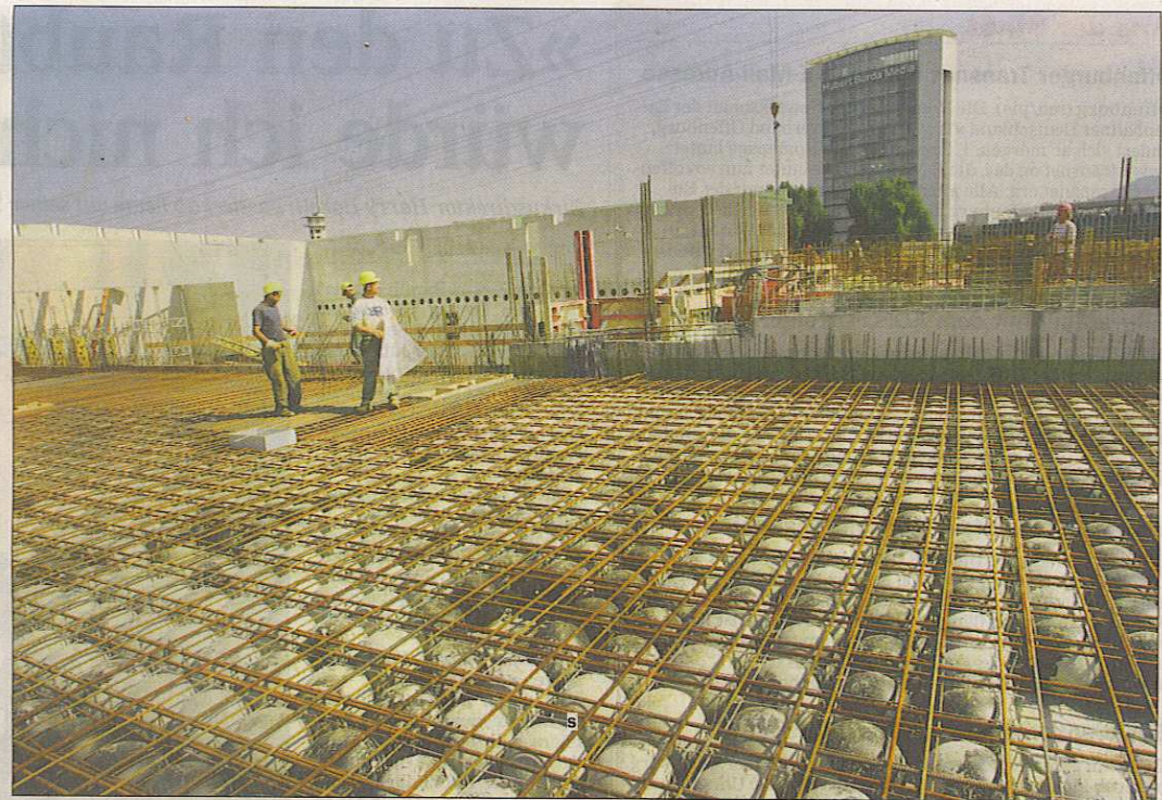
Hartplastikkugeln statt schwerem Beton: Dank des neuartigen Konstruktionssystems aus der Schweiz werden am Dach der neuen Oberrheinhalle rund 300 Tonnen Beton eingespart. Dadurch wurde deutlich weniger Fundament bei der Halle benötigt. Fotos: U. Marx
