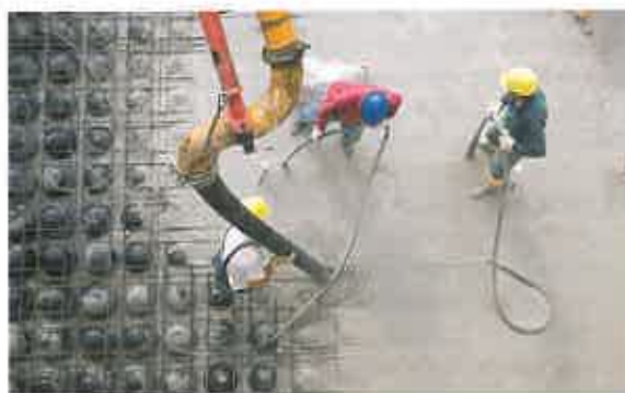
Bild 3. Betonage einer Cobiax-Hohlkörperdecke (Fotos: Cobiax Technologies)
